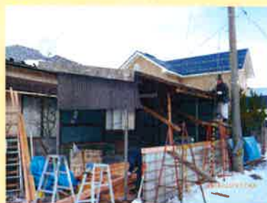
外部車庫改修工事
